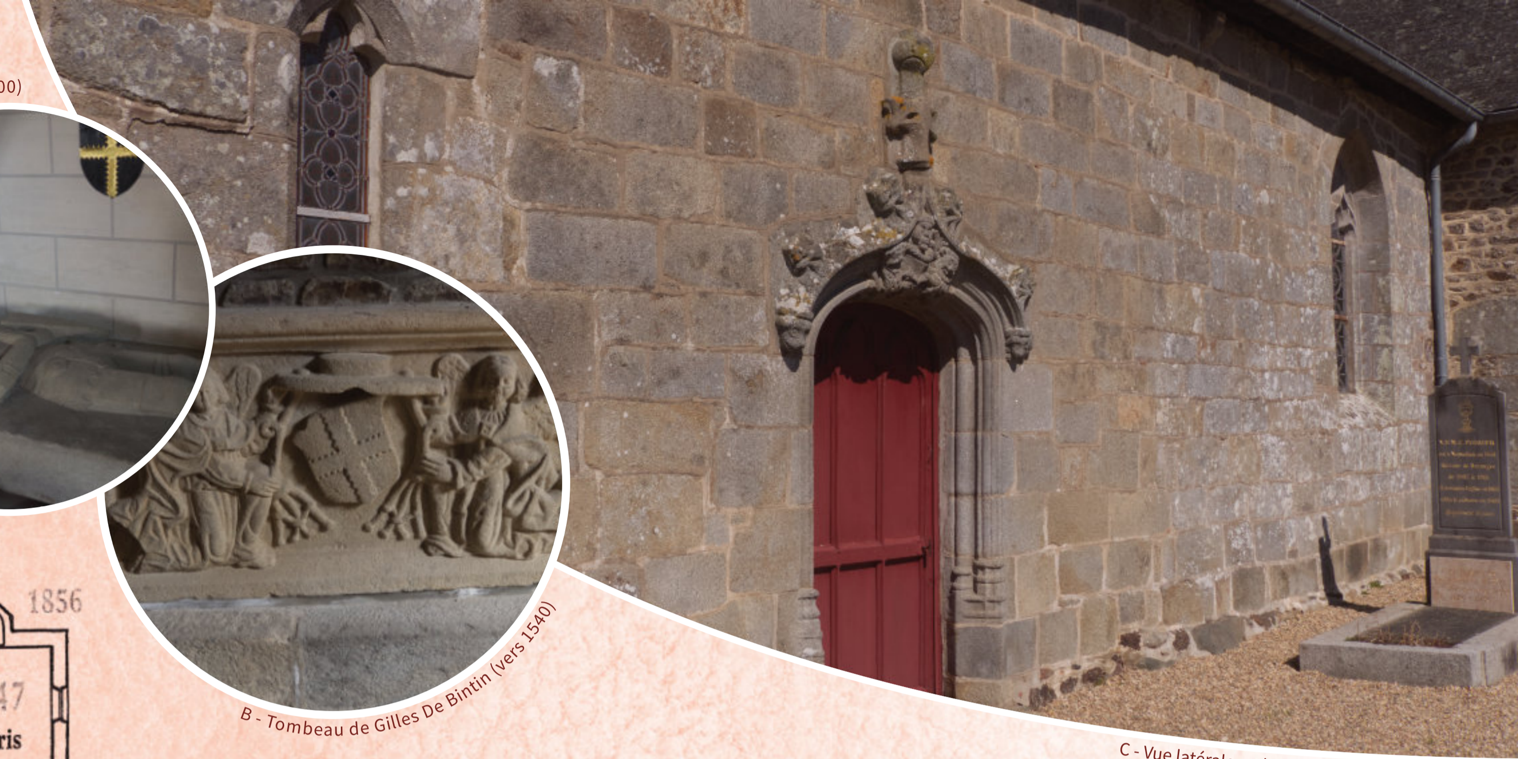
C - Vue latérale sud
