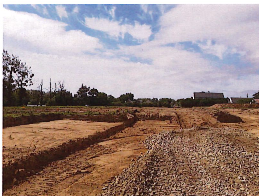
Juillet 2024- terrassement secteur 2
