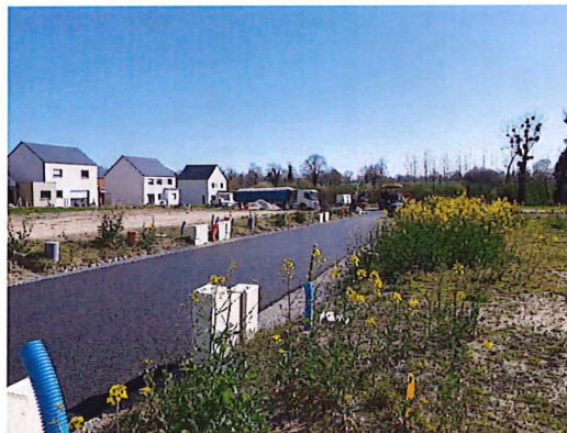
Avril 2025 – revêtement provisoire secteur 2
